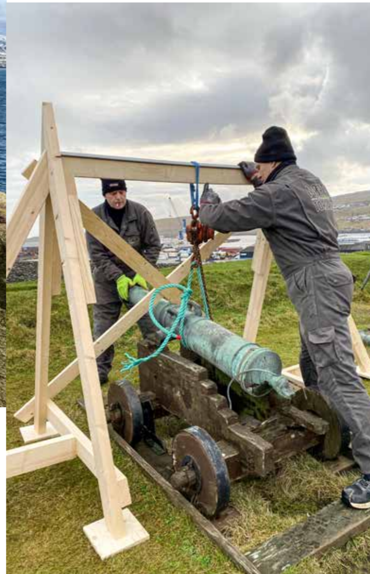
Eitt timburstillads var bygt fyri lættari at fáa tungu kanónirnar av og á undirløgini. Á myndini sýggjast Martin Mørk og Ingi Tórgarð
