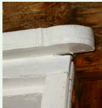
Myndin vísir úrslitið av restaureringsarbeiðinum. Profilurin sæst illa á fyrri myndini, har sum hann sæst væl á seinni myndini
